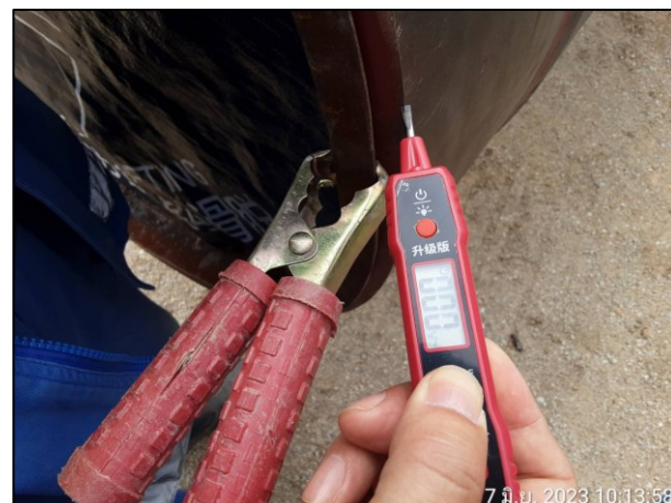
ค) การต่อสายดินกับท่อที่วางเรียงได้ส่งไฟฟ้าแรงสูงโดยใช้ปากคีบบริเวณที่จับ (Clamp) กับท่อส่งก๊าซธรรมชาติ
