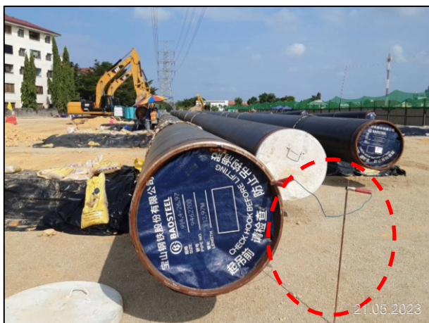
ค) การต่อสายดินกับท่อที่วางเรียงได้ส่งไฟฟ้าแรงสูงโดยใช้ปากคีบบริเวณที่จับ (Clamp) กับท่อส่งก๊าซธรรมชาติ
