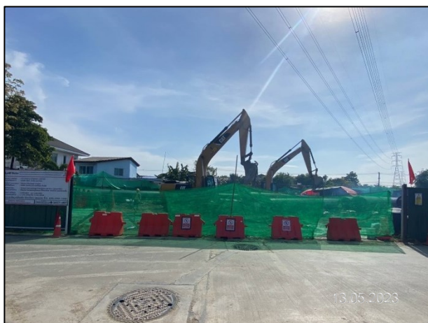
รูปที่ 2-5 ติดตั้งแผงพลาสติก/ผ้าใบ เพื่อป้องกันการฟุ้งกระจายของฝุ่นละอองในบริเวณพื้นที่ก่อสร้าง
