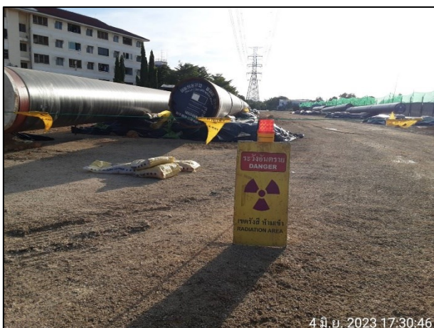
ข) การกั้นเขตและการติดตั้งป้ายระวังอันตรายเขตรังสีห้ามเข้าในบริเวณที่ดำเนินการตรวจสอบรอยเชื่อมด้วยรังสี
