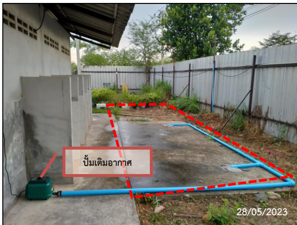
ถังบำบัดน้ำเสียแบบเติมอากาศบริเวณพื้นที่จัดเก็บท่อ/วัสดุอุปกรณ์
