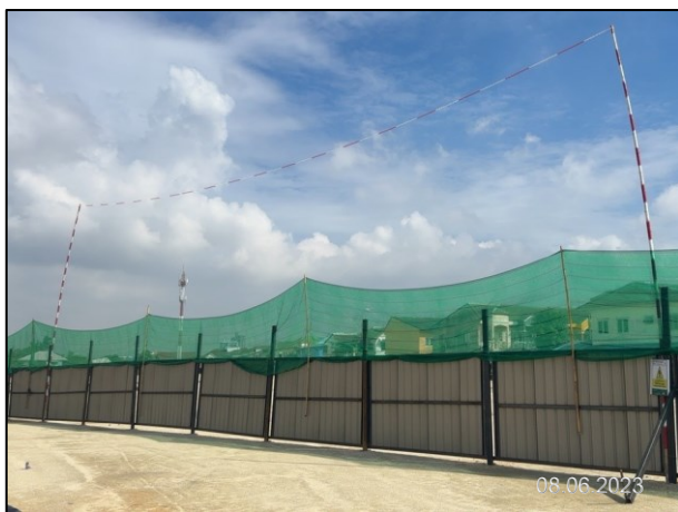
ข) การติดตั้ง Goal post เป็นสัญลักษณ์ระยะปลอดภัยจากสายส่งไฟฟ้าแรงสูง
