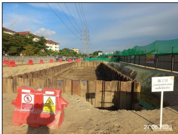
รูปที่ 2-12 การติดตั้ง Sheet pile ป้องกันการพังทลายของดินบริเวณบ่อรับ-บ่อส่ง
