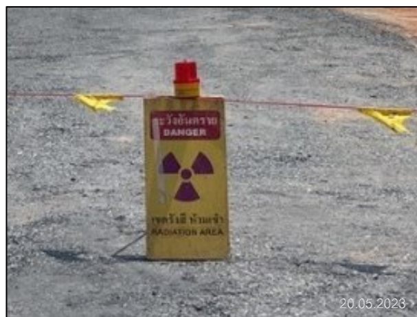
ข) การกั้นเขตและการติดตั้งป้ายระวังอันตรายเขตรังสีห้ามเข้าในบริเวณที่ดำเนินการตรวจสอบรอยเชื่อมด้วยรังสี
