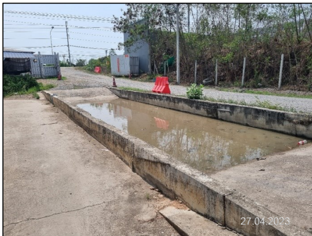
รูปที่ 2-8 การจัดทำพื้นที่ล้างล้อทำความสะอาดดินและเศษโคลนที่ติดกับล้อรถ ก่อนออกจากพื้นที่เก็บกองท่อ (Stock Yard)
