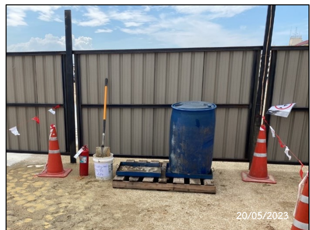
รูปที่ 2-19 จัดเตรียมภาชนะรองรับป้องกันการหกรั่วไหลของน้ำมันและสารเคมี พร้อมทั้งวัสดุดูดซับ
