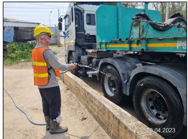
รูปที่ 2-8 การจัดทำพื้นที่ล้างล้อทำความสะอาดดินและเศษโคลนที่ติดกับล้อรถ ก่อนออกจากพื้นที่เก็บกองท่อ (Stock Yard)
