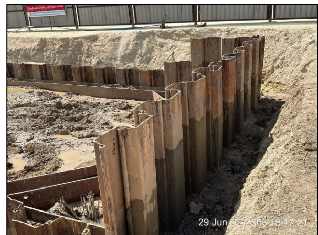
รูปที่ 2-12 การติดตั้ง Sheet pile ป้องกันการพังทลายของดินบริเวณบ่อรับ-บ่อส่ง
